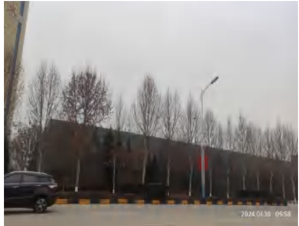
厂区北侧（科技创新孵化园）
