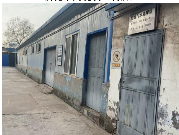
综合污水处理站现状（依托）
