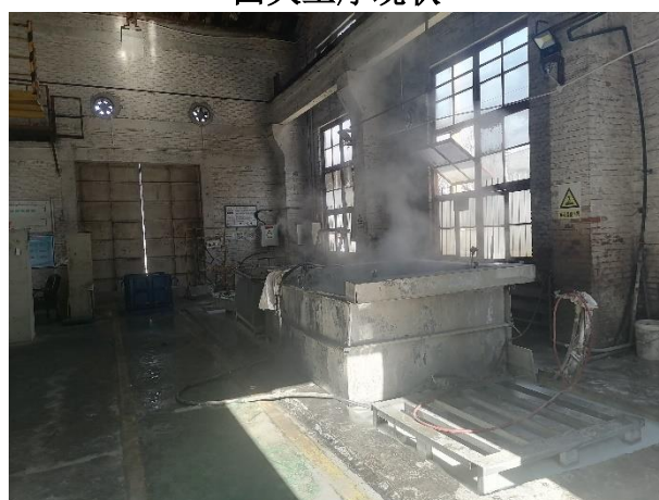
磷化车间现状（利旧）
