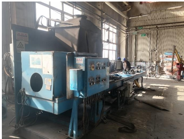
已建焊机（改造）及拟建焊机现状
