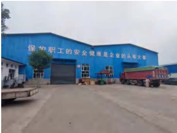
厂区东侧（虎工园区内部）
